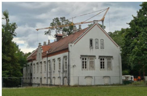
Obnova Novih dvora, srpanj 2025.
